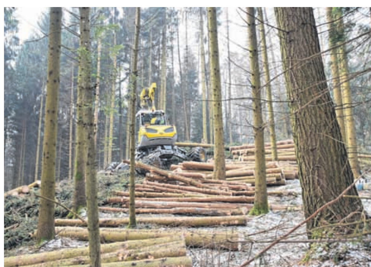
Nebst stark beschädigten Bäumen hat das Kreisforstamt auch lädierte Bäume zum Fällen markiert. Dank guter Wetterbedingungen kommen die Aufräumarbeiten zurzeit gut voran.
